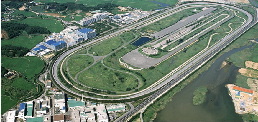
Figure 6.3. 실차 환경 평가 주행 도로
